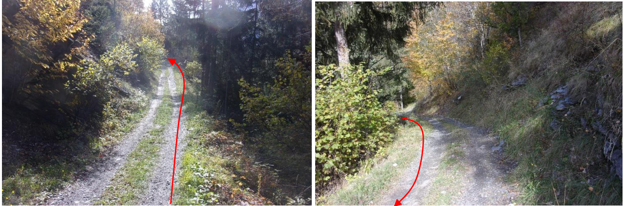
Cheminement conduite forcée sous la piste, côté aval
